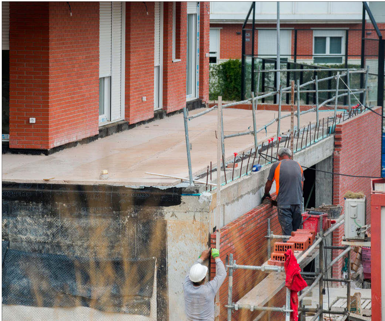
Dos obreros durante un proceso de construcción residencial en la ciudad de Burgos. TOMÁS ALONSO
